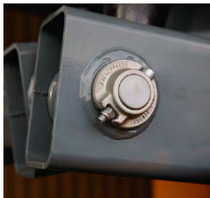
Tratamiento anticorrosión de los ejes, la tornillería y las piezas pintadas
