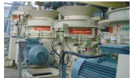
Instalación fija : un molino de cono Metso HP500, un HP300, dos HP200.
